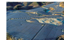
太陽光パネル
