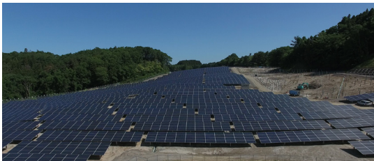
大規模太陽光発電所の工事が順調に進む（福島・左）、発電予定量（右）
